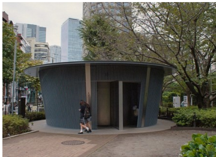
«Tokyo Toilet» parc Nabeshima Shôtô (Mori no Komichi)
